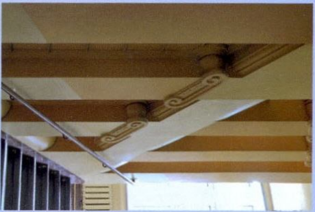
Dekoracja klatki schodowej – w starej części szkoły
