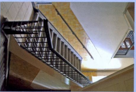
Klatka schodowa w nowej części szkoły
