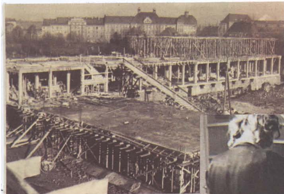
Budowa kolejnego gmachu Politechniki —
