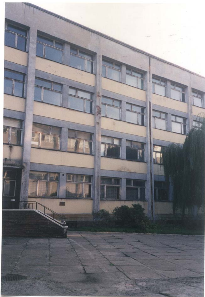
Ogólny widok frontowej ściany budynku przed wymianą okien
